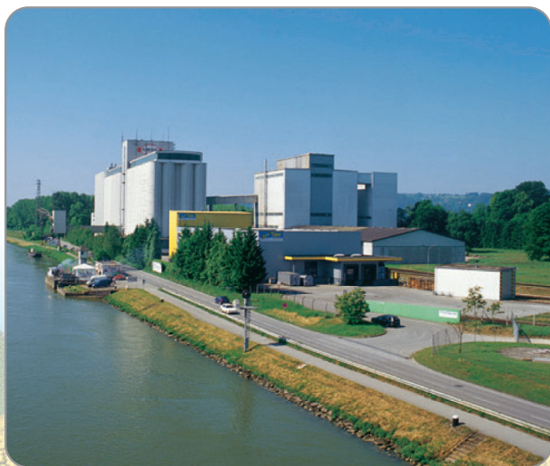
Rozlewnia oleju w Aschach, Austria
